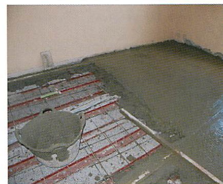
Relleno de la zona de entrevigado con mortero aligerado.
