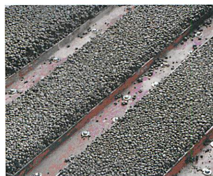
Forjado con la pieza de refuerzo ensamblada.
